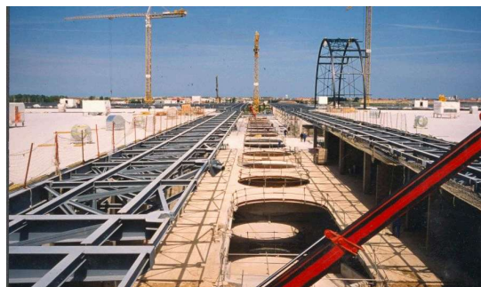
Un chantier impressionnant fait de béton, et de tôle. Georges Floret
