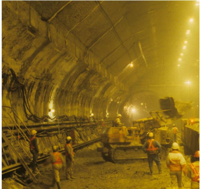
150 kilomètres de tunnels ont été forés dans des conditions de travail difficiles.
